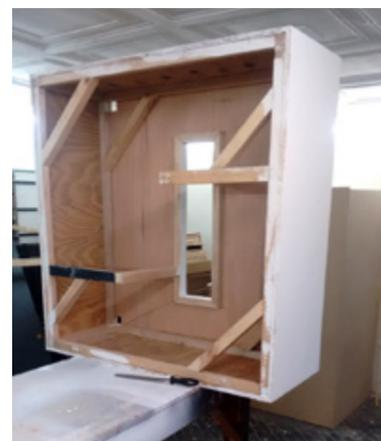
Proceso de construcción del pedestal: impermeabilización y pintura.
